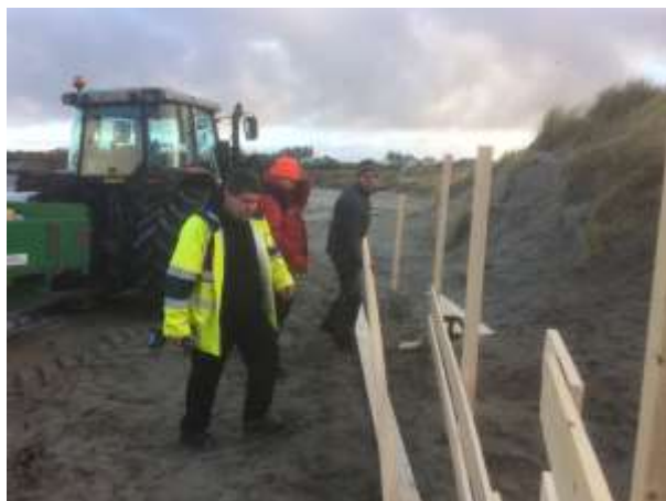
Godt arbeidslag—montere sandfangergjerder.
